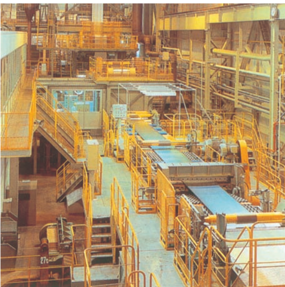
電気亜鉛めっき設備
